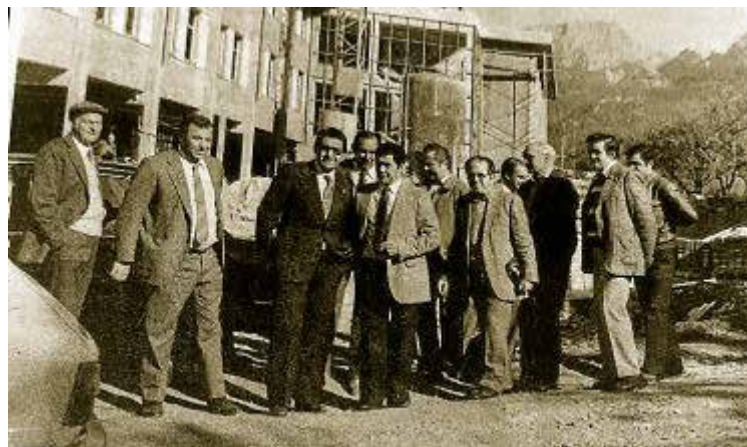
Jeroni Albertí visità les obres el novembre de 1980.
